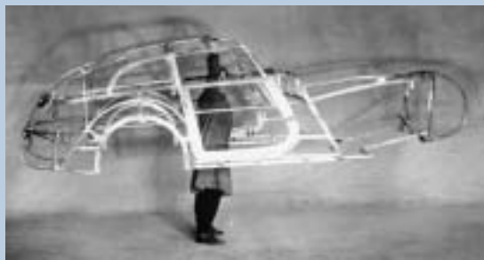
Der Gitterrohrrahmen für das Kamm-Coupé AM 1008 (links) war aus Elektron und wog nur 30 kg. Rechts das fertige Kamm-Coupé bei Testfahrten am Flughafen Oberwiesenthal.
